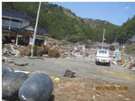
1階部分が流された家屋。山積みの瓦礫
