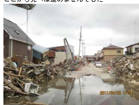
瓦礫、浸水（地盤沈下）
